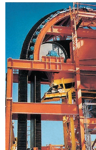
Строительство тоннеля, известняк, 1200 т/ч
